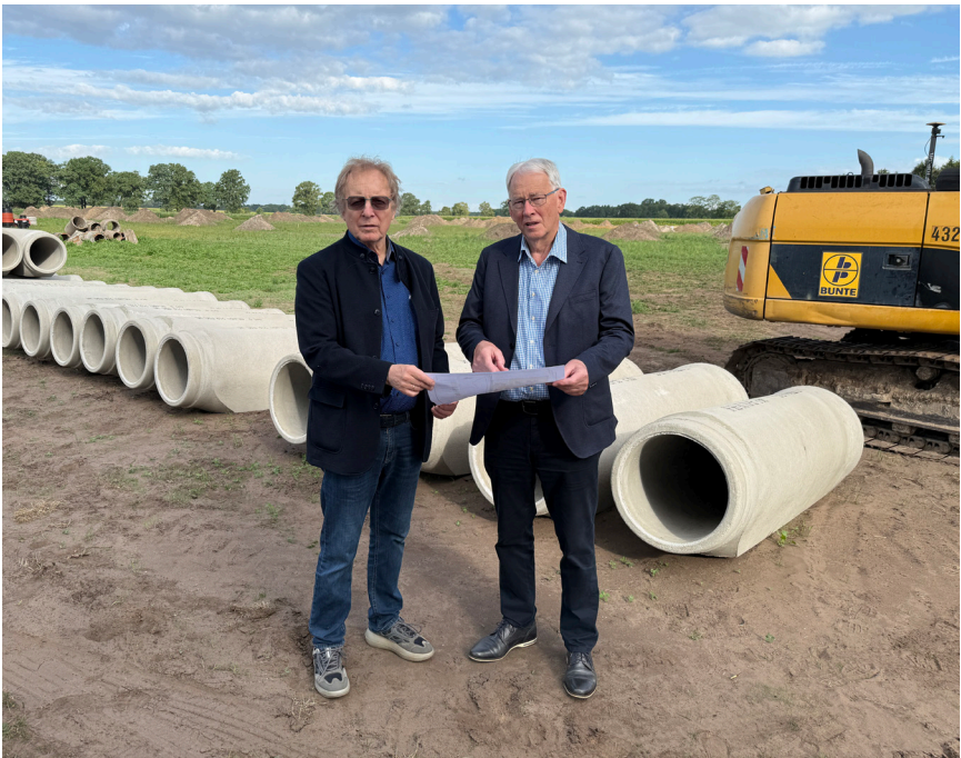
Erschließungsarbeiten für das neue Baugebiet: Stellvertretender Bürgermeister Karl-Hans Harren (links) und Bürgermeister Hermann Borchers am Koopsweg. (Foto: Daniel Mäß)
