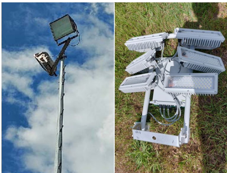
Die alten Lampen der Flutlichtmasten (links) wurden abmontiert und durch moderne LED-Flutlicht-Körper (rechts) ersetzt. (Fotos: Gemeinde Neulehe)
