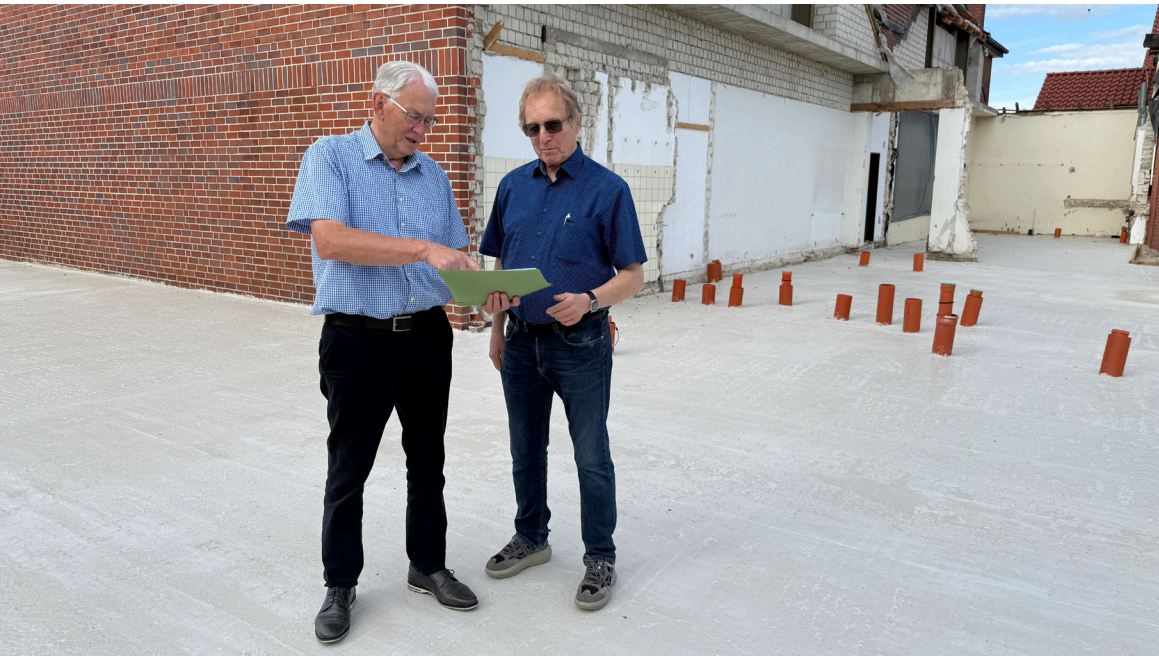
Bürgermeister Hermann Borchers (links) und sein Stellvertreter Karl-Hans Harren stehen auf der neu gegossenen Bodenplatte für die Erweiterung der Sporthalle. (Foto: Daniel Mäß)
