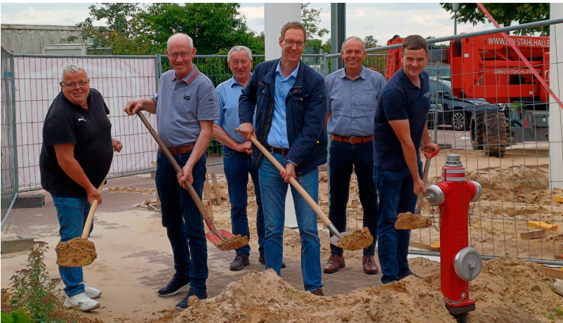
...als auch in Dersum die Spatenstiche für umfassende Baumaßnahmen vornehmen. (Fotos: Samtgemeinde Dörpen)
